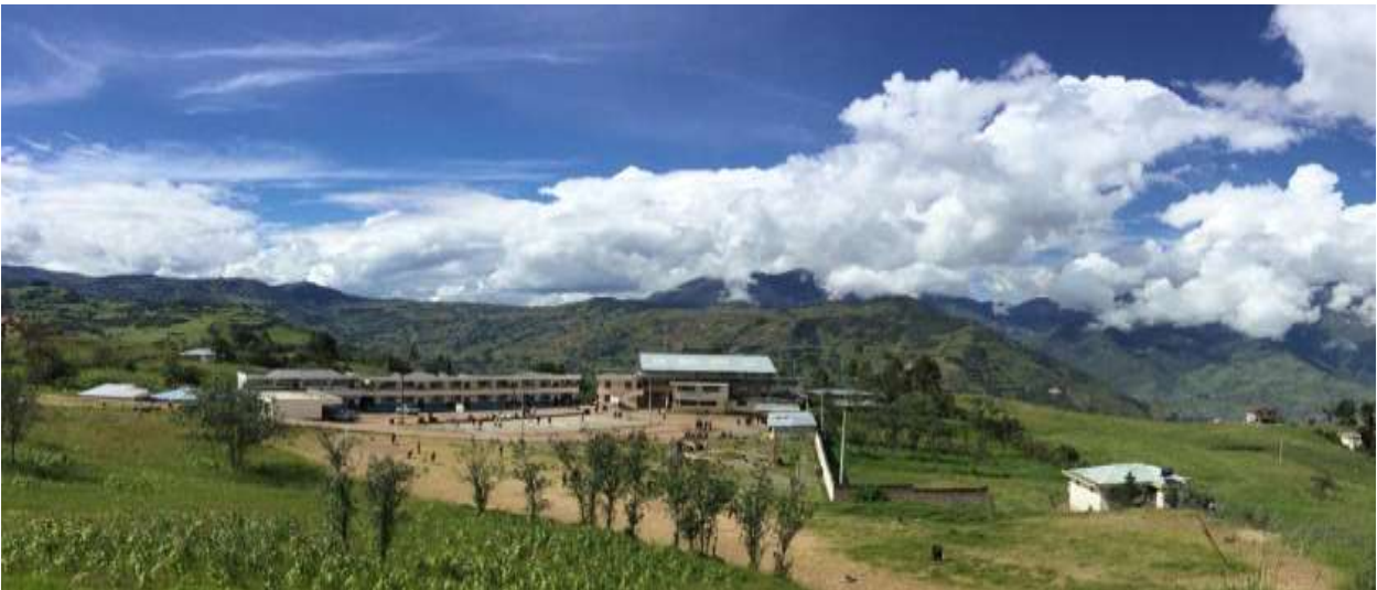
Imagen 3: Unidad Educativa Comunitaria Intercultural Bilingüe "Suscal". Fuente: fotografía propia, 2017.
